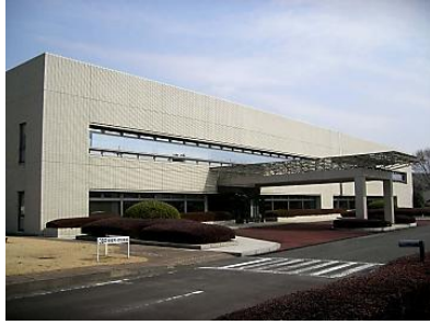
熊谷組技術研究所 本館（管理棟）
