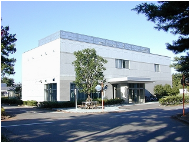
中央農業総合研究センター 環境保全型病害虫防除技術 開発共同実験棟
